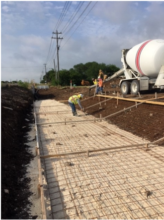
1. Macias Pouring Concrete Rip Rap S of Hy Rd
