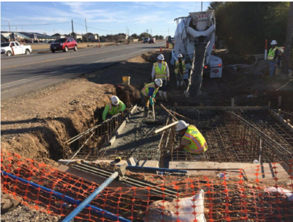
3. Sterling Pouring SET S of Hy Rd
